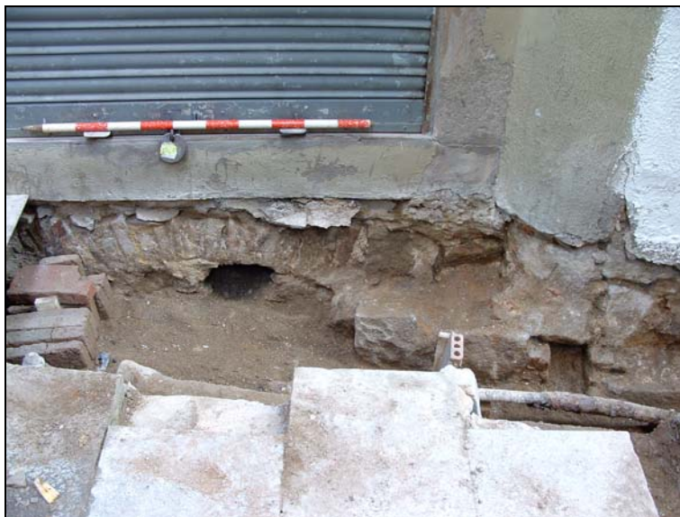
F5: Detall de la canalització vertical UE 08 i del possible arc UE 11.
