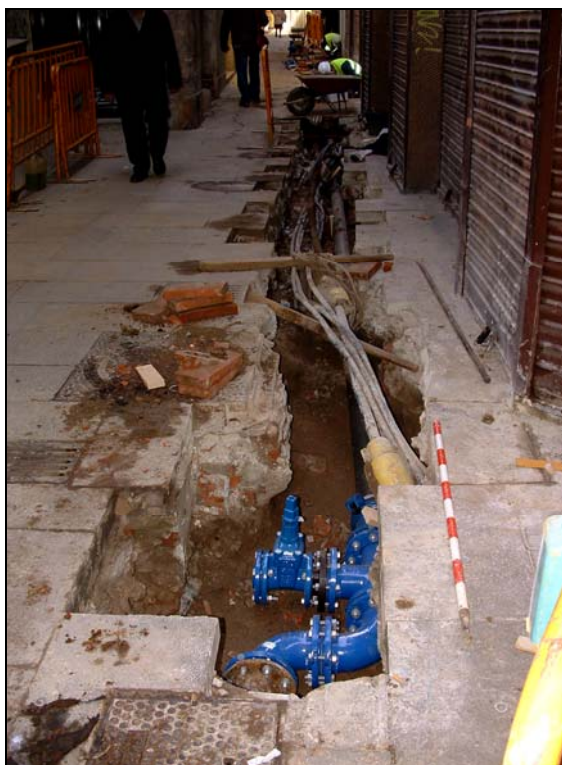
F1: Vista general de l'extrem meridional de la rasa.
